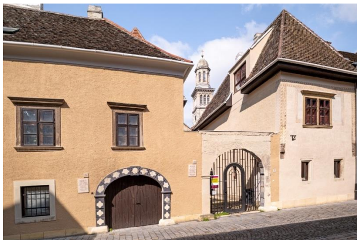
1. ábra: Az Új utca 22-24. épületek felújított homlokzatai (Fotó: Tóth Richárd)
